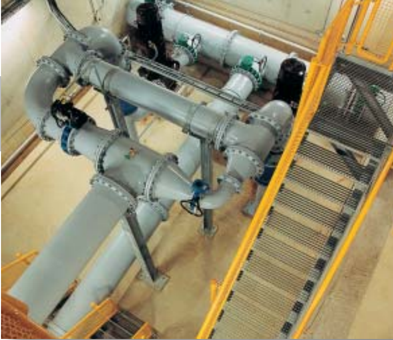
Rilsan/Trinkwasser Pumpwerk
